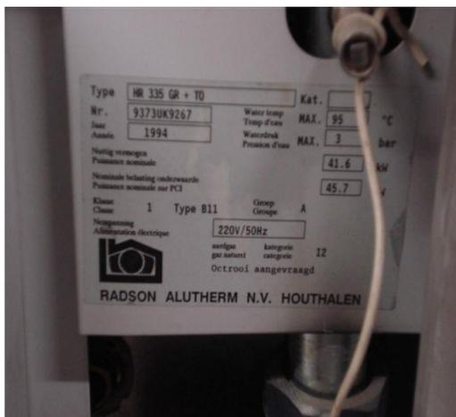
Figure 15. : Plaque signalétique chaudière gaz
