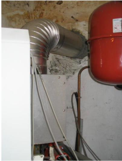
Figure 25. : Evacuation des fumées (raccordement cheminée non-conforme)
