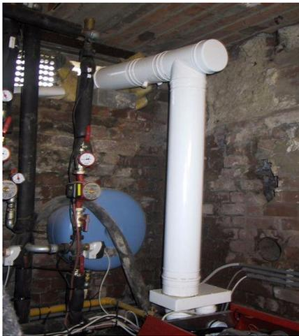
Figure 27. : Chaudière de type C1\* avec arrivée d'air fermée
