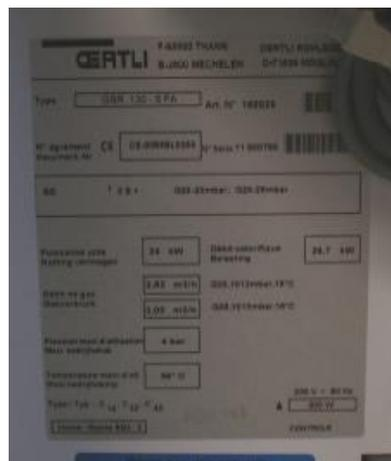
Figure 16. : Plaque signalétique chaudière atmosphérique
