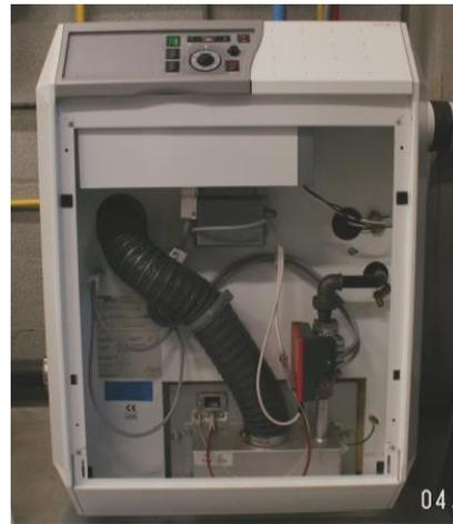
Figure 28. : Chaudière au gaz à arrivée d'air étanche (type C)
