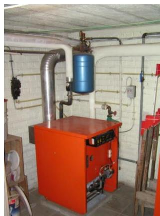
Figure 24. : Chaudière atmosphérique de type B11 avec évacuation des fumées en cheminée
