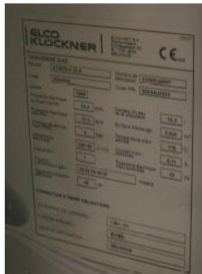
Figure 14. : Plaque signalétique chaudière gaz
