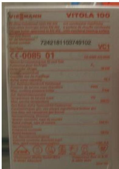
Figure 13. : Plaque signalétique chaudière fuel
