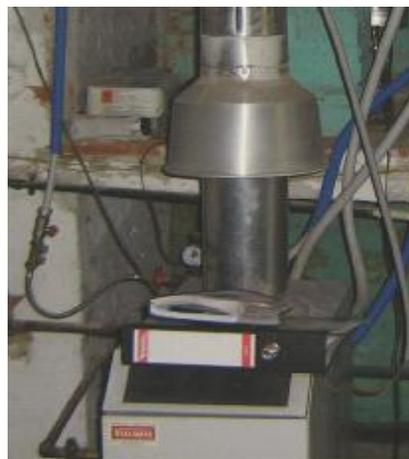
Figure 22. : Chaudière avec coupe-tirage anti-refouleur
