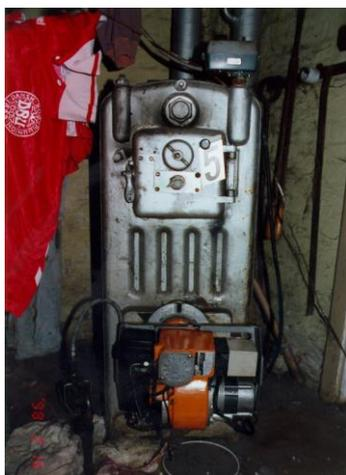
Figure 8. : Exemple extrême d'une vieille chaudière non isolée
