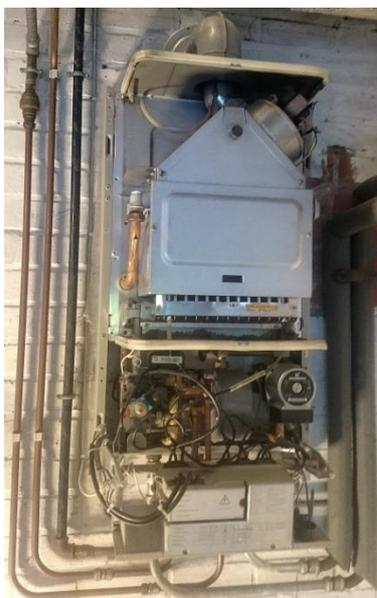
Figure 10. : Exemple de chaudière atmosphérique raccordée en C13
