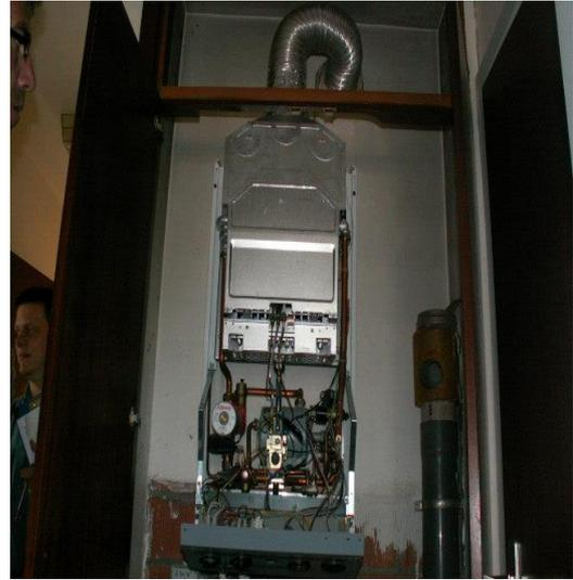
Figure 26. : Chaudière atmosphérique murale au gaz type B11 (raccordement cheminée non-conforme)
