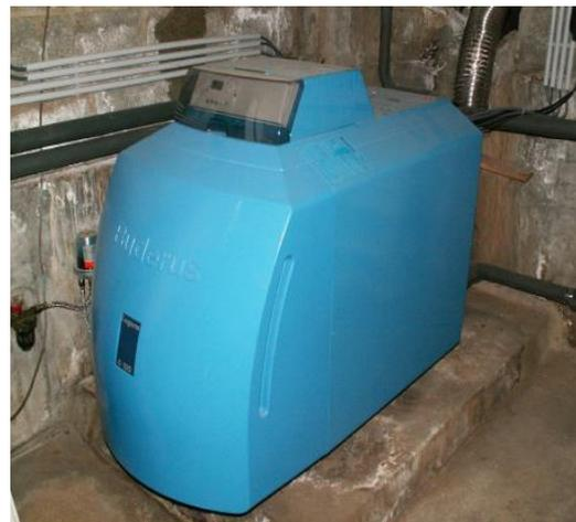
**Figure 4. : Exemple de chaudière moderne**
