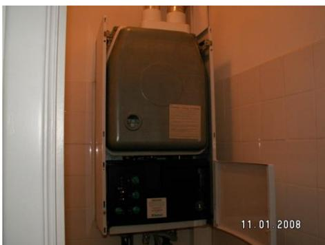
Figure 29. : Chaudière murale au gaz (type C)
