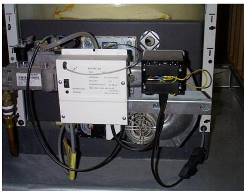
Figure 31. : Chaudière au gaz avec brûleur prémix
