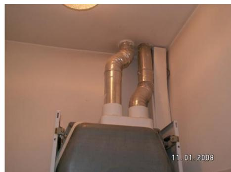
Figure 30. : Appareil fermé (type C)
