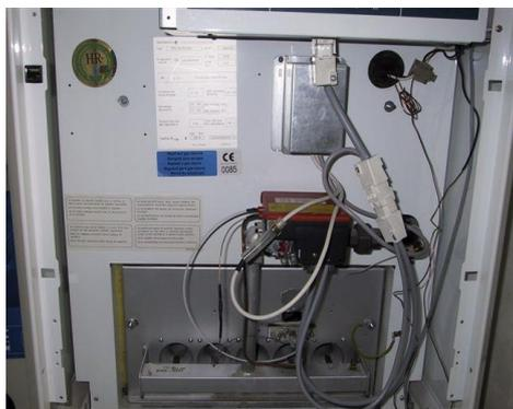
Figure 23. : Brûleur d'une chaudière atmosphérique gaz de type B11
